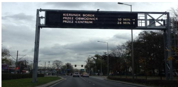
Rys. 2. Przykład wykorzystania inteligentnych systemów transportowych do zarządzania ruchem ulicznym poprzez informacje na znakach zmiennowskazaniowych
