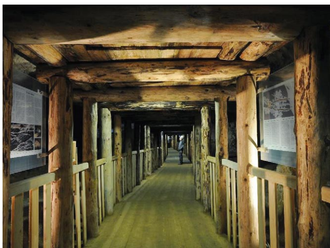
Rys. 4. Tomaszów Mazowiecki – Groty Nagórzyckie – projekt obudowy górniczej dla wydzielonej trasy turystycznej
