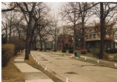
Ryc. 5. Riverside w 2002 r. Olmsed, Vaux & Co., początek przedsięwzięcia w 1868 r. (Fot. P. Wolski)
