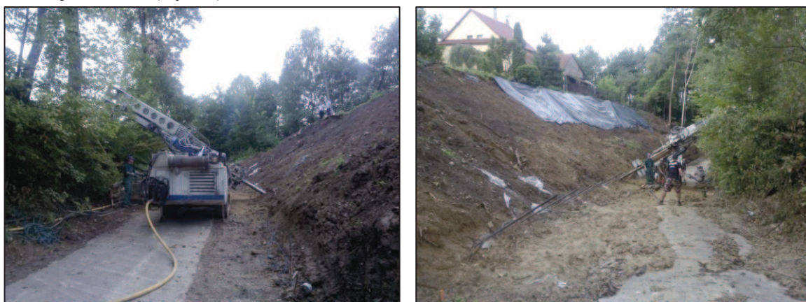
Rys. 4. Wykonywanie kotew gruntowych u podnóża skarpy osuwiskowej (fot. Ligęza)
