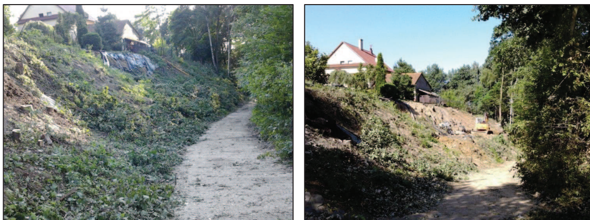
Rys. 3. Usunięcie roślinności i wierzchniej warstwy gruntu na skarpie osuwiskowej (fot. Turecki)
