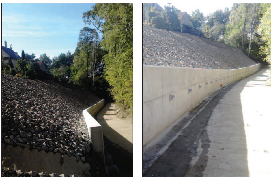
Rys. 6. Efekt końcowy stabilizacji (fot. Bosak)
