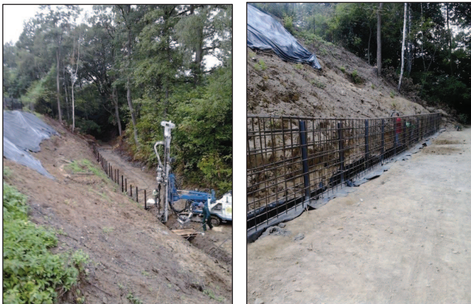
Rys. 5. Wykonywanie mikropali, na których posadowiono ścianę oporową (fot. Bosak)
