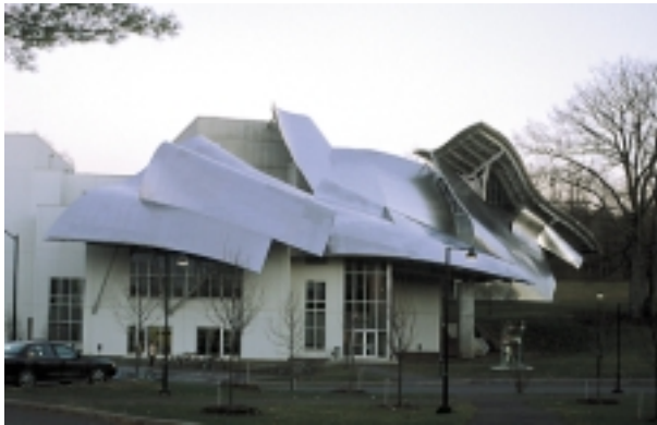
Fot. 8. EMP w Seattle, detal elewacji. Autor: Błażej Kotelko
