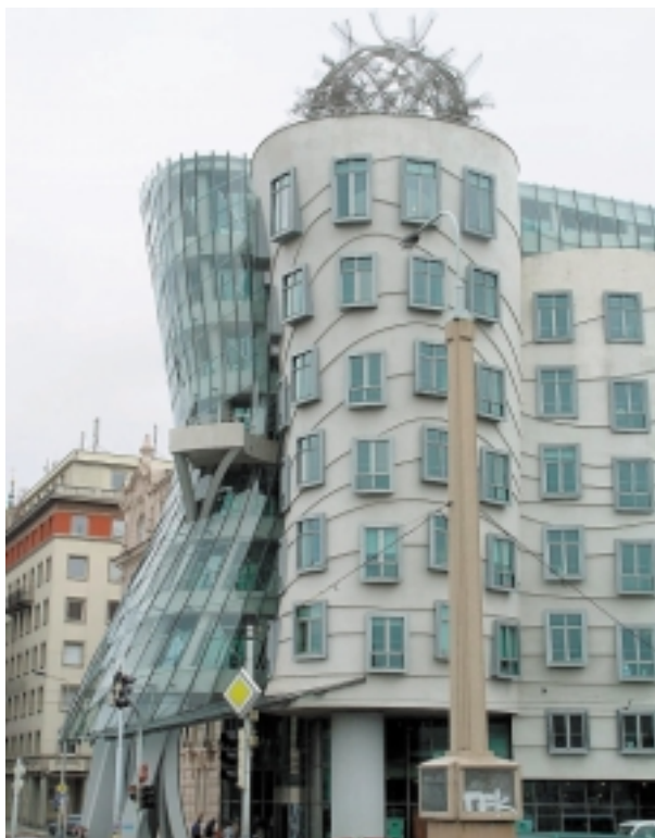
Fot. 1. Dwie wieże w budynku ING w Pradze. Autor: Barbara Widera
