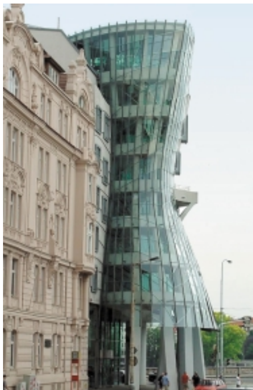
Fot. 4. Budynek ING, fragment elewacji prostopadłej do rzeki. Autor: Barbara Widera
