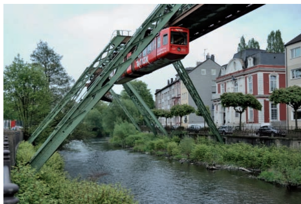
Rys. 4. Kolej wisząca w pobliżu ul. Ufer (Uferstraße), Wuppertal, (8.05.2010 r.) [fot. Mbdortmund / Wikimedia Commons]
