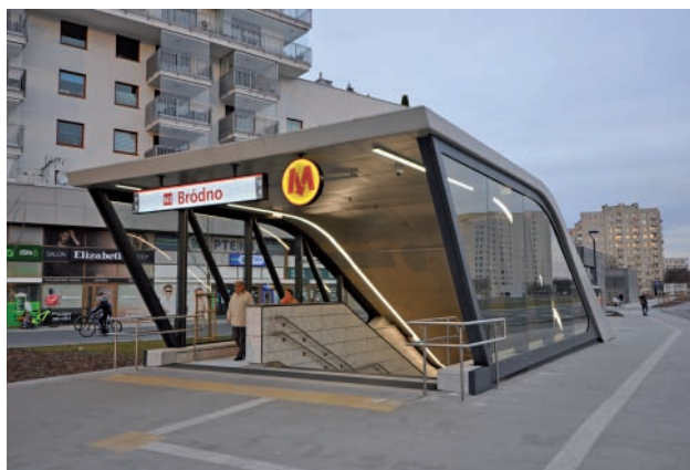
Rys. 9. Wejście do stacji Bródno (18.03.2023 r.) [fot. M. Graff]
