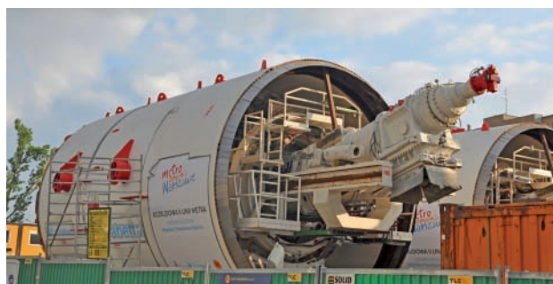
Rys. 18. TBM Elisabetta na terenie przyszłej stacji Bemowo (13.06.2020 r.) [fot. M. Graff]
