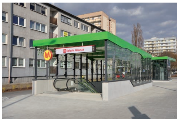
Rys. 15. Wejście do stacji Księcia Janusza (04.04.2020 r.) [fot. M. Graff]
