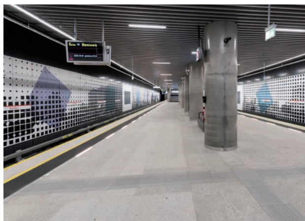
Rys. 13. Stacja Bródno (01.10.2022 r.) [fot. A. Grycuk / Wikimedia Commons]
