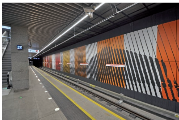
Rys. 12. Stacja Kondratowicza (18.03.2023 r.) [fot. M. Graff]
