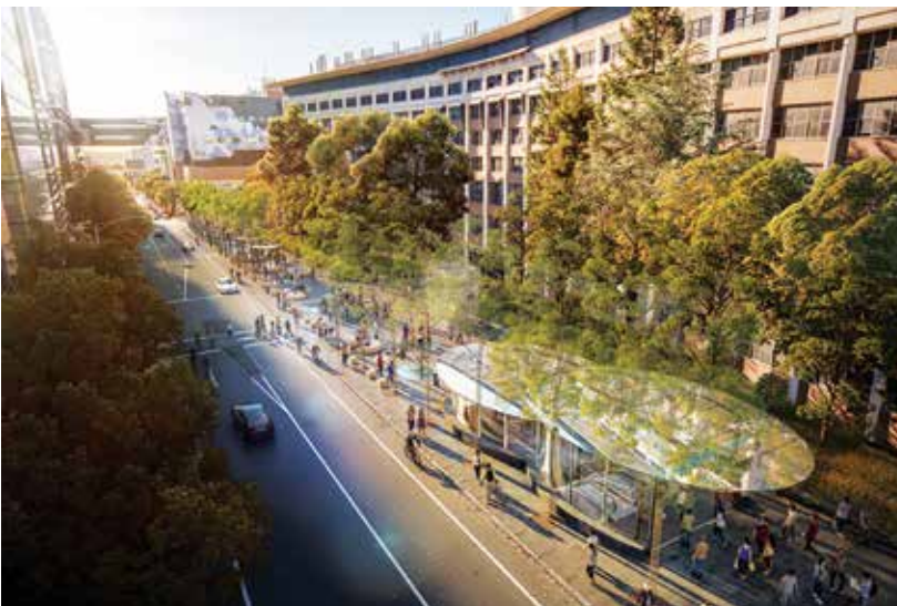
Rys. 5. Stacja Parkville zlokalizowana bezpośrednio przy obiektach University of Melbourne i ośrodkach naukowo-badawczych i medycznych Źródło: http://metrotunnel.vic.gov.au .
