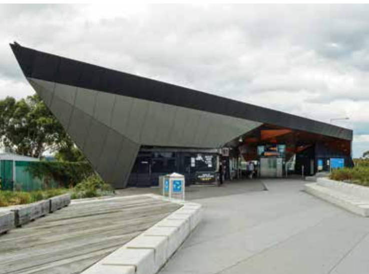
Fot. 2. Nowy budynek stacji Epping (linia South Morang). Fot. Thebusofdoom, Wikipedia
