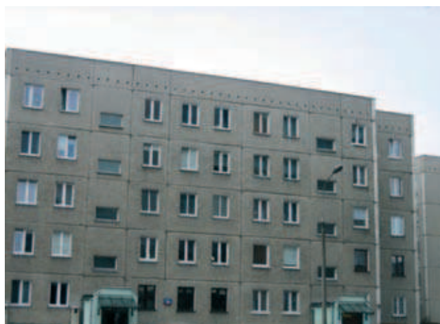
Rys. 3. Przykład wielokopłytowego budynku mieszkalnego (fot. J. Szulc)
