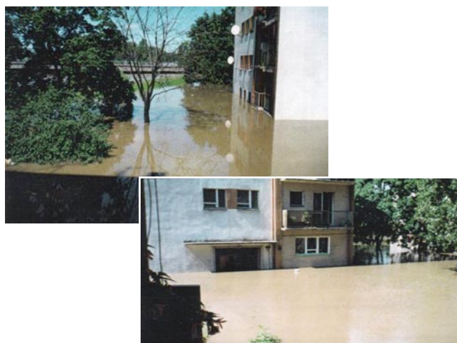
Rys. 6. Budynek zalany wodami powodziowymi do połowy wysokości parteru (sierpień 1997) – archiwum autora
