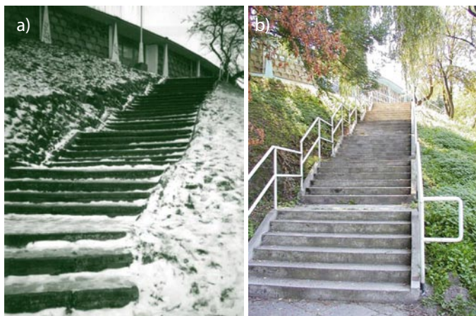
Rys. 9. Amfiteatr 1000-lecia: a) zdeformowane kamienne schody skarpy (grudzień 1997), b) nowe, żelbetowe konstrukcje schodów (wrzesień 2003) – archiwum autora
