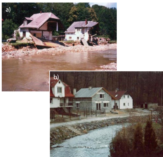
Rys. 5. Szkody powodziowe: a) dwa budynki mieszkalne uszkodzone przez falę powodziową (sierpień 1997), b) nowe budynki, wybudowane w miejscu uszkodzonych (październik 1998) – archiwum autora
