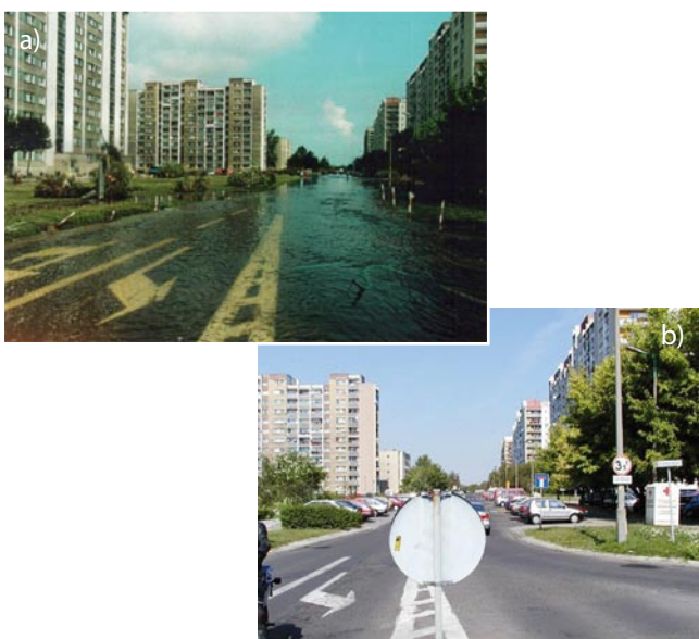
Rys. 8. Budynki mieszkalne 11-kondygnacyjne: a) w czasie opadania wód powodziowych, b) 6 lat po powodzi (wrzesień 2003) – archiwum autora
