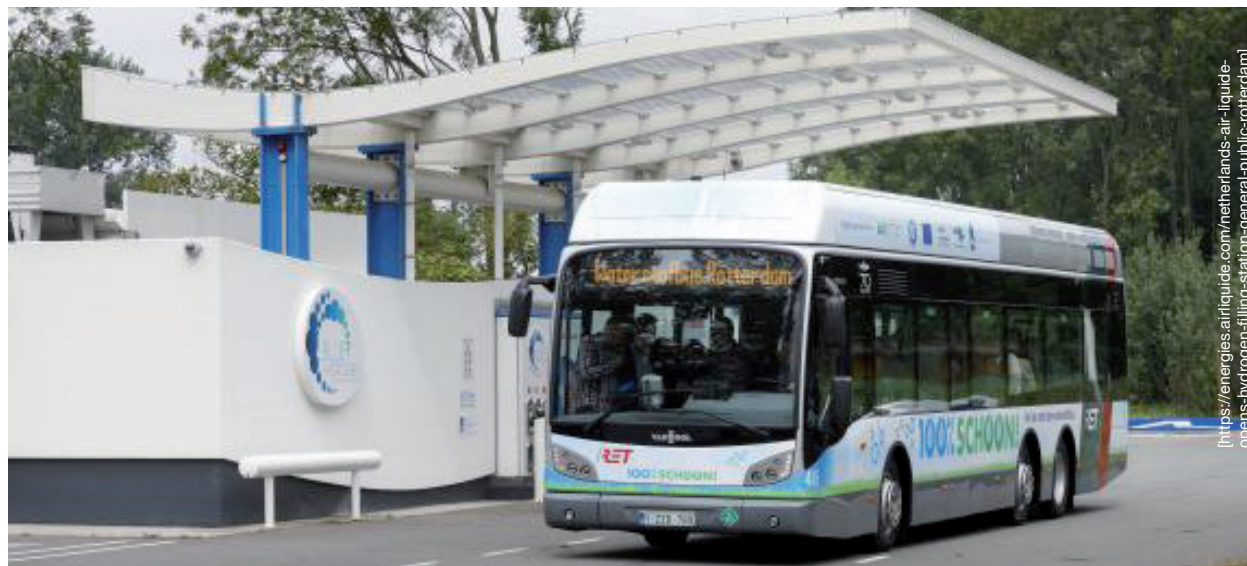
Rys. 6. Stacja tankowania wodoru przystosowana do odbioru wodoru z rurociągu w Rotterdamie, z ciśnieniem tankowania 350 i 700 bar
