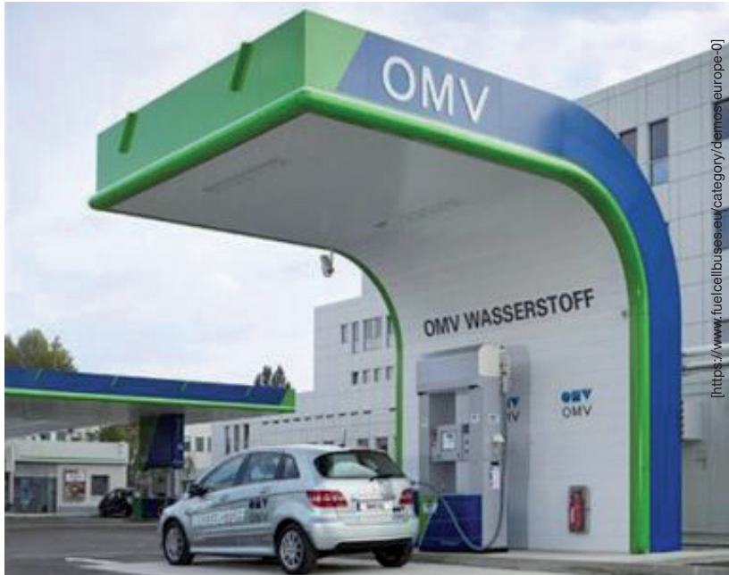
Rys. 3. Stacja tankowania wodoru na lotnisku w Stuttgarcie, z dowozem wodoru z zewnątrz i ciśnieniem tankowania 350 i 700 bar
