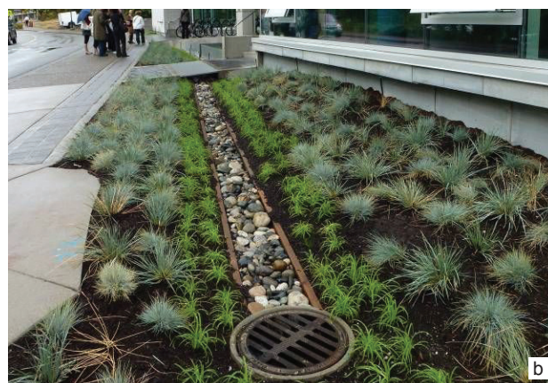
Il. 8. System gospodarki wodą: a) dach obiektu wykonany z białej folii izolacyjnej tworzący rodzaj wanny służącej do zbierania wody deszczowej, b) kanały i rowy, które w naturalny sposób rozprzewadzą oczyszczoną wodę na działce
