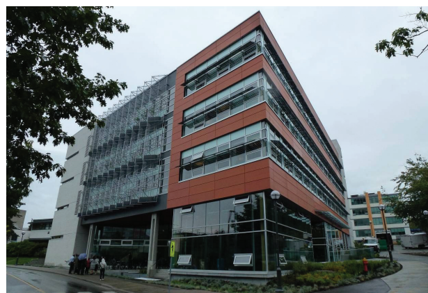
Il. 1. Widok na budynek CIRS z rogu West Mall i ul. Sustainability
