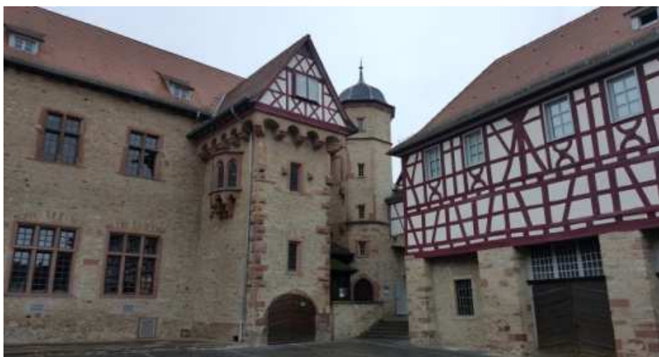
Rys. 18. Budynek Sądu Elektoratu Moguncji w Heppenheim obecnie. Widok na wykuszowe okno mieszczące kapliczkę oraz gotycką wieżę. Fot. Autorzy, 2016
