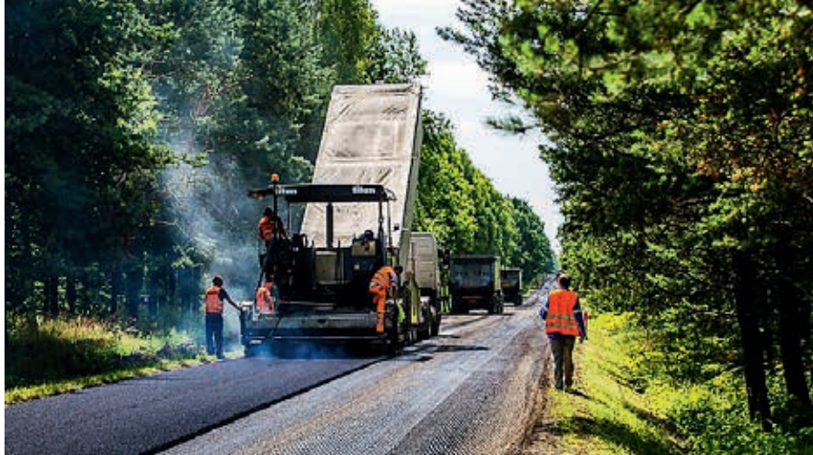
Zastosowanie asfaltu bardzo wysoko modyfikowanego produkcji LOTOS Asfalt w Świerklańcu
