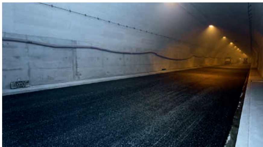
Nawierzchnia Tunelu pod Martwą Wisłą w Gdańsku z zastosowaniem asfaltu MODBIT
