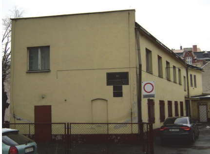
Rys. 6. Dom Technika w Jeleniej Górze
