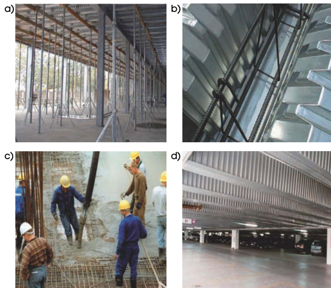
Rys. 6. Montaż stropu Sweddeck [4], [5]: a) podparcie stropu przed betonowaniem, b) widok zbrojenia żebra, c) betonowanie stropu, d) widok wykonanego stropu
