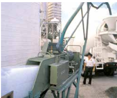
Fot. 2. Urządzenie do schładzania mieszanki betonowej ciekłym azotem bezpośrednio w bębnie betonomieszarki samochodowej [15]
