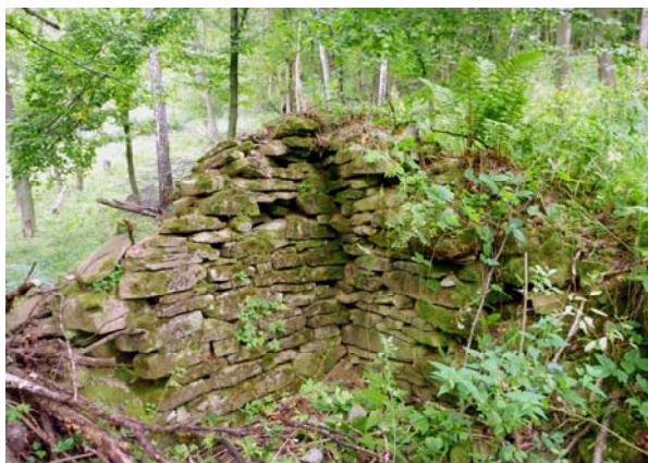
Fot. 3. Ruiny kamiennego budynku. Photo 3. Ruins of stone building.
