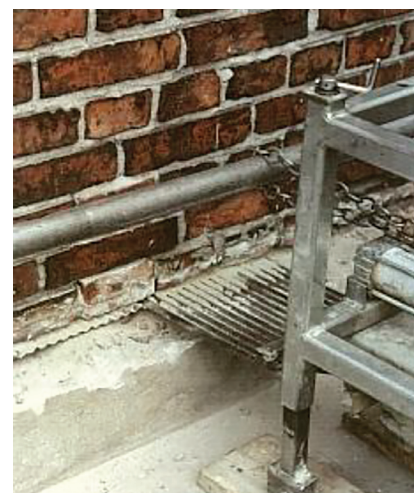
Rys. 3. Wbijanie blachy w spoinę za pomocą młota pneumatycznego [3]
