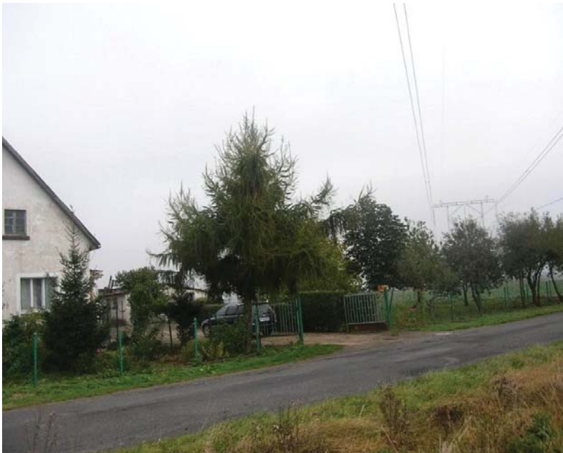
Rys. 1. Przykład zbliżenia linii 400 KV do zabudowy mieszkalnej na terenie Dolnego Śląska
