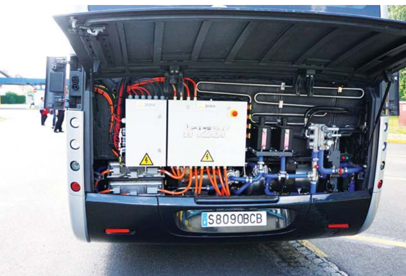
Tylna komora ie-tram, w której zamontowano układy sterowania mocą
