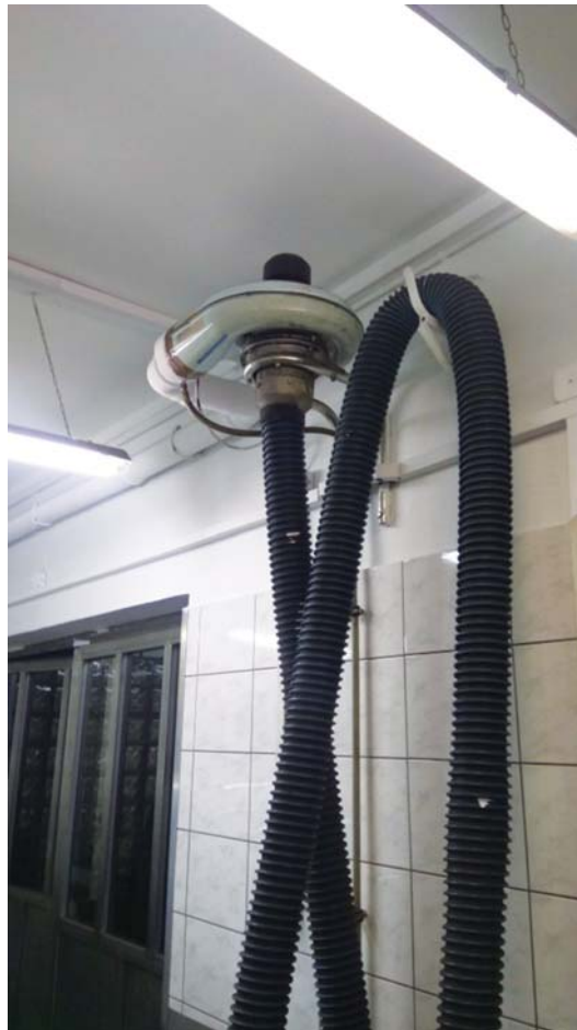
Wyciąg spalin stosowany powszechnie w serwisach wymaga zgłoszenia organowi ochrony środowiska z racji wymuszonej cyrkulacji spalin [10]
