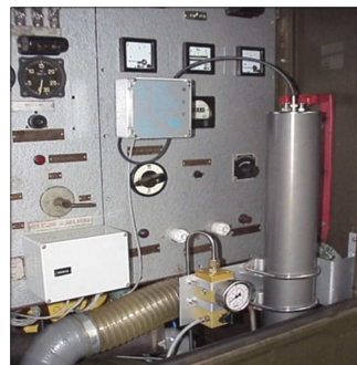
Rys. 3. Filtr uzdatniania powietrza oddechowego firmy BAUER typu P61(a); ogólny widok filtra po zamontowaniu w zestawie zasilania bazy zabezpieczenia prac podwodnych "ORTOLAN"(b). (a i b), źródło: (a)materiały informacyjne producenta, (b)badania własne.
