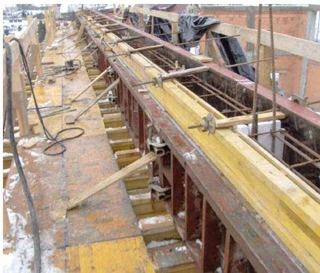
Rys. 9. Gotowe deskowanie belki Bz-6 przed betonowaniem; źródło: fotografie własne autora
