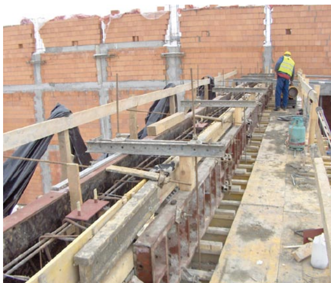
Rys. 10. Wzmocnienie deskowania belki Bz-6 (opis w tekście), źródło: fotografie własne autora
