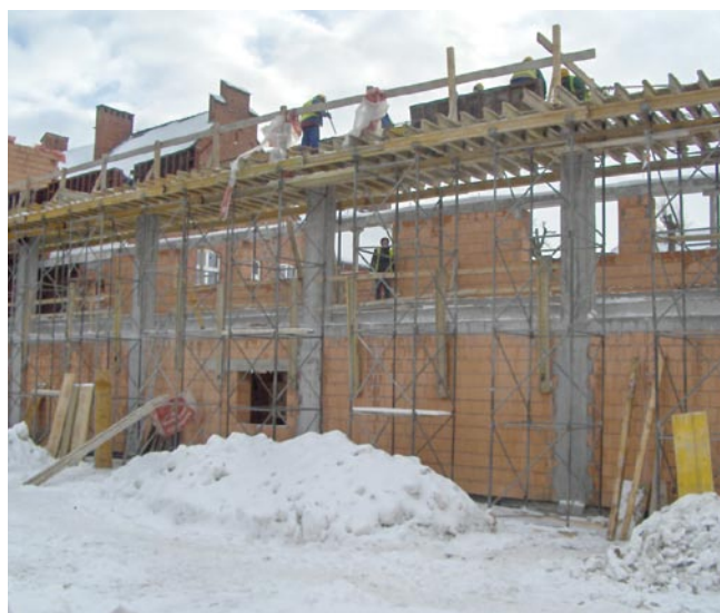
Rys. 8. Rusztowanie podporowe deskowania belki Bz-6; źródło: fotografie własne autora
