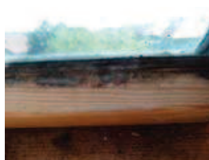
Rys. 10. Ościeżnice pokryte grzybami pleśniowymi
