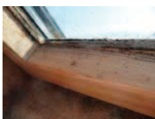
Rys. 11. Styk między szybą a ramą okienną wypełniał się kondensatem i zaopatrywał mikrostrzęfę w wodę niezbędną do rozwoju grzybów pleśniowych
