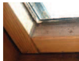
Rys. 10. Ościeżnice pokryte grzybami pleśniowymi
