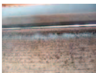
Rys. 11. Styk między szybą a ramą okienną wypełniał się kondensatem i zaopatrywał mikrostrzęfę w wodę niezbędną do rozwoju grzybów pleśniowych
