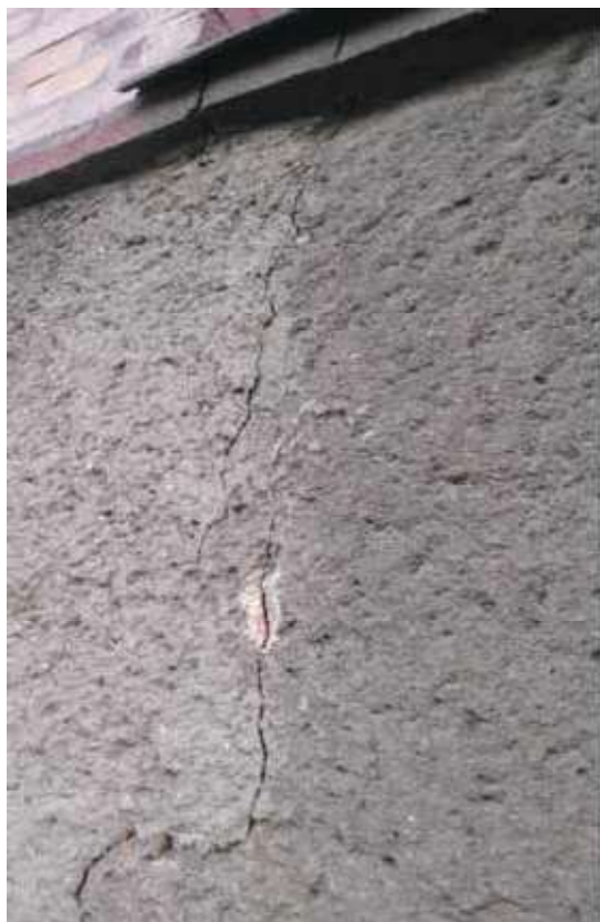
Rys. 14. Zarysowania monitorowanej południowej ściany budynku powstałe w trakcie prowadzonej w tym miejscu eksploatacji
