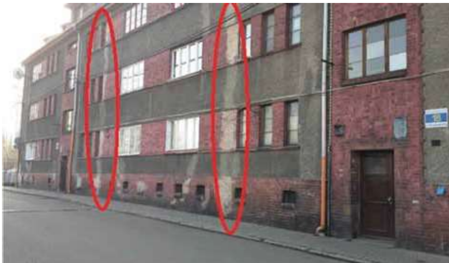
Rys. 5. Strefy osłabione w przeszłości, obecnie przemurowane, bez zarysowań na zewnętrznej, podłużnej ścianie południowej (stan na październik 2014)
