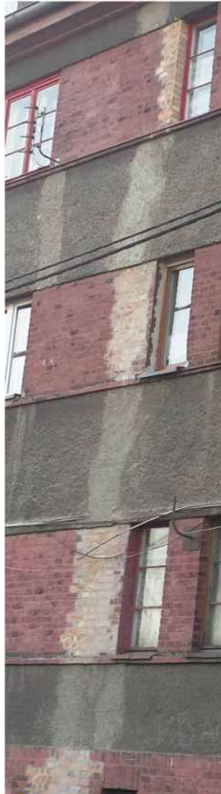
Rys. 16. Przemurowanie nr 1 (stan na październik 2014) Fig. 16. Re-bricking no. 1 (as for October 2014)
