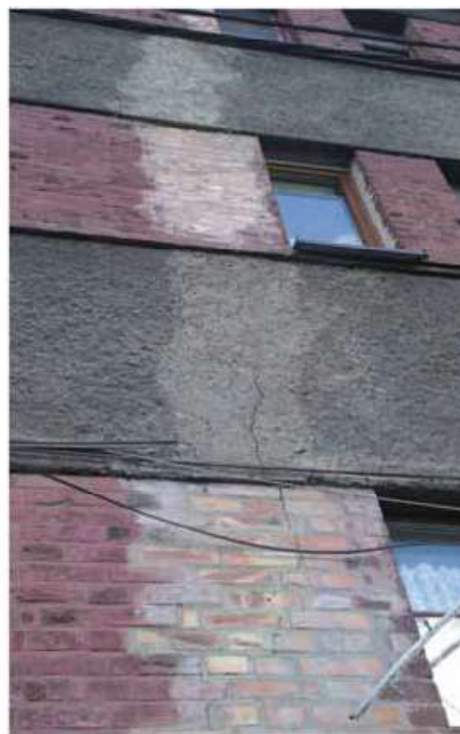
Rys. 14. Zarysowania monitorowanej południowej ściany budynku powstałe w trakcie prowadzonej w tym miejscu eksploatacji
