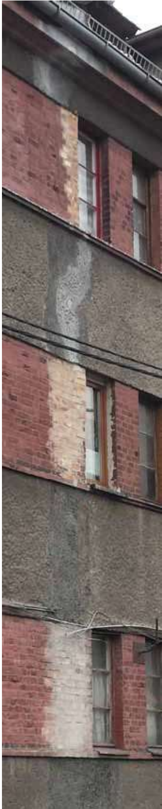
Rys. 15. Przemurowanie nr 1 (stan na grudzień 2016) Fig. 15. Re-bricking no. 1 (as for December 2016)
