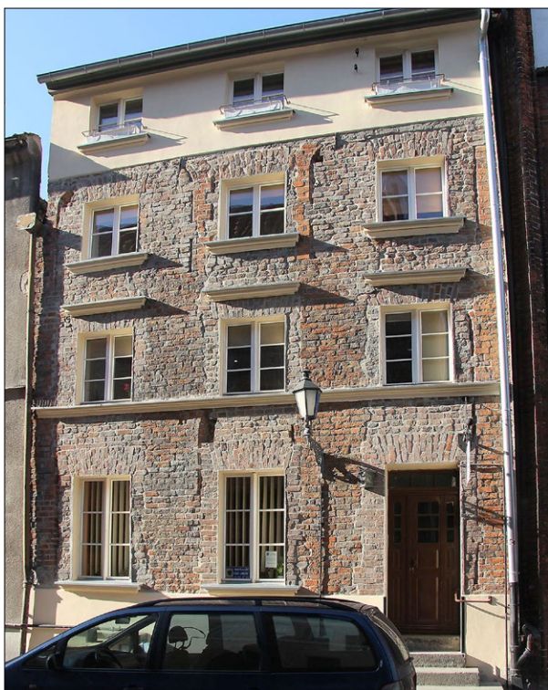
Ryc. 9. Kamienica przy ul. Piekary 7 po pracach konserwatorskich; bez jakiegokolwiek ingerencji budowlanej uczyniona została średnio-wieczna artykulacja, przekształcona w XIX w.; fot. M. Prarat 2019.
