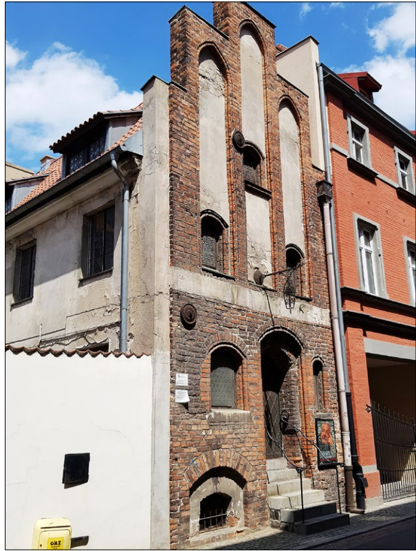
Ryc. 6. Szczyt kamienicy przy ul. Rabiańskiej 24; oznaczenia: A – przed podjęciem prac w latach 50. XX w. z widocznymi konsolkami szczytu półkolistego (zbiory Katedry Konserwatorstwa); B – po pracach odtwarzających błędnie szczyt schodkowy; fot. M. Prarat 2019.
