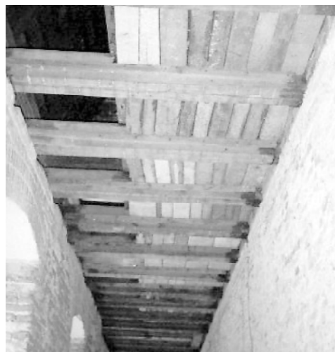
Rys. 5. Odślonięte belki stropu drewnianego nad korytarzem
