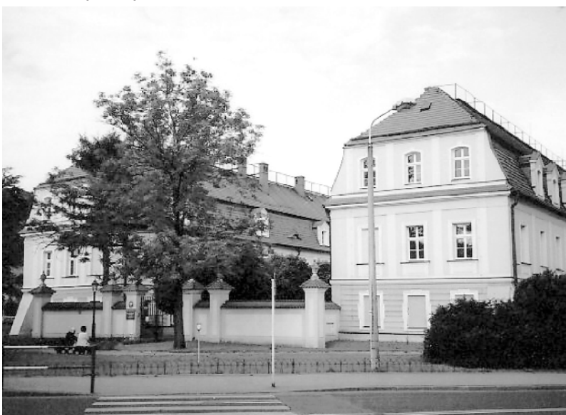
Rys. 9. Widok skrzydeł bocznych zamku od strony wschodniej
