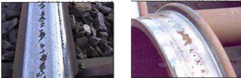
Rys. 1. Zniszczenia szyny (na lewo) i koła (po prawej)
