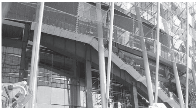
Rys. 2. Widok ogólny schodów po obudowaniu konstrukcją stalową
