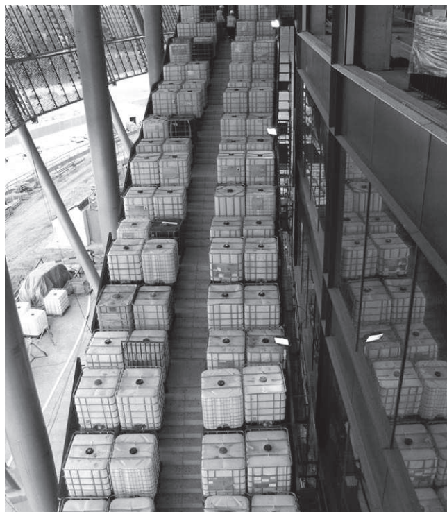
Rys. 5. Widok schodów w czasie próbnego obciążenia statycznego (fot. T. Wierzbicki)
