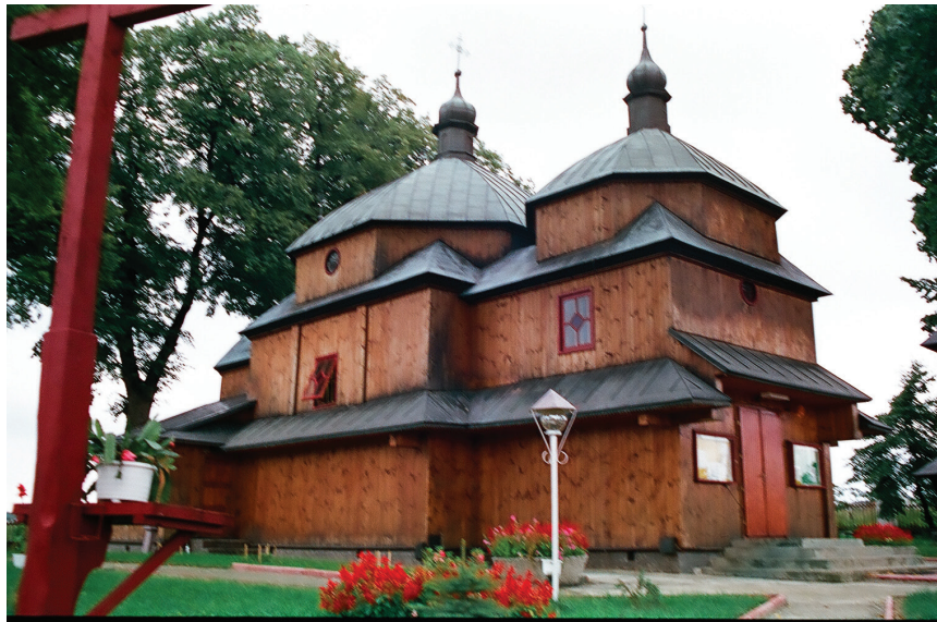
Fot. 1. Zubowice – dawna cerkiew parafialna pw. Św. Michała Archanioła, wygląd po remoncie w 1982 (fot. aut.)
