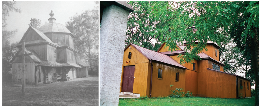
Fot. 3. Sulimów – dawna cerkiew filialna pw. Św. Jana Ewangelisty – fot. archiwalna sprzed remontu [4] i po przekształceniu w latach 1981–82 (fot. aut.)
