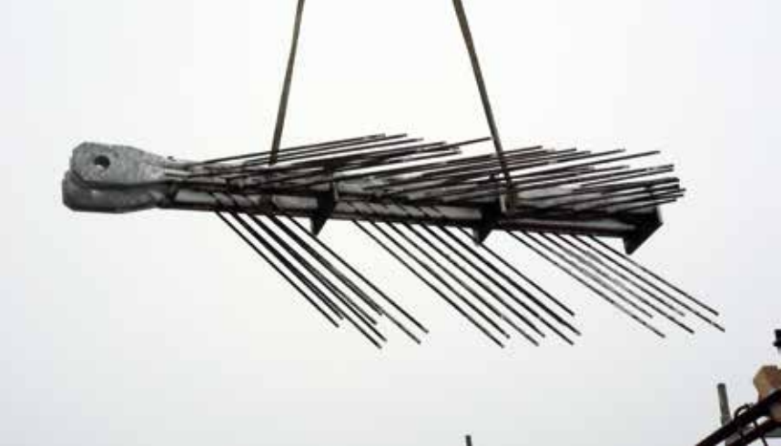
Element zakotwienia konstrukcji stalowej
