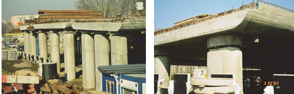
Rys. 3. Widok ogólny podpory P1 w trakcie budowy (2000r.)
