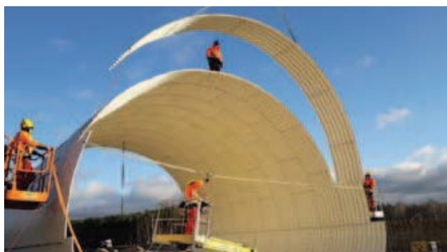
Rys. 10. Montaż elementów przejścia
