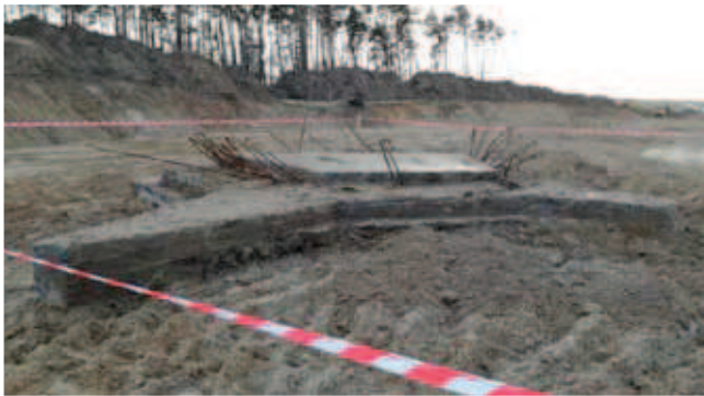
Rys. 5. Fundament tradytora dwustronnego
