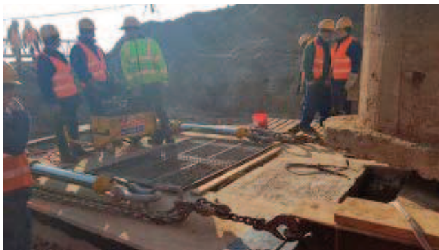
Rys. 8. Ruszt stalowy na podkładkach ślizgowych
