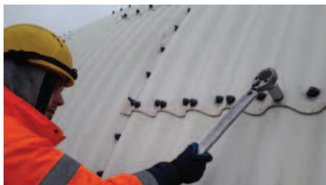
Rys. 11. Dokręcanie śrub
