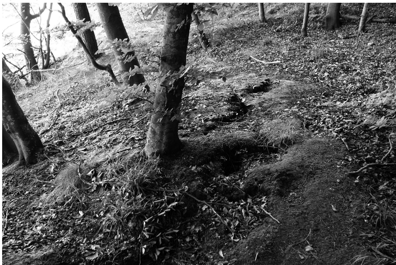
Ryc. 11. Świeża szczelina inicjalna powstała w efekcie destabilizacji zaplecza klifu (osuwisko I), 15.03.2007 Fig. 11. Newly formed dilatation crack as an effect of destabilization of the back of the cliff (landslide I), 15.03.2007
