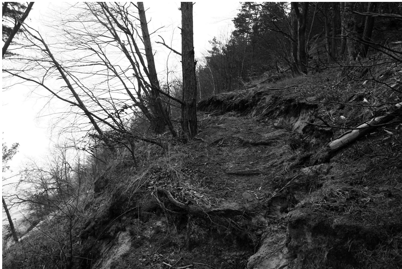
Ryc. 10. Zerwa krawędziowa wykształcona w efekcie destabilizacji strefy krawędziowej klifu (osuwisko I), 16.12.2006 Fig. 10. Edge slump initiated as an effect of cliff edge area destabilization (landslide I), 16.12.2006
