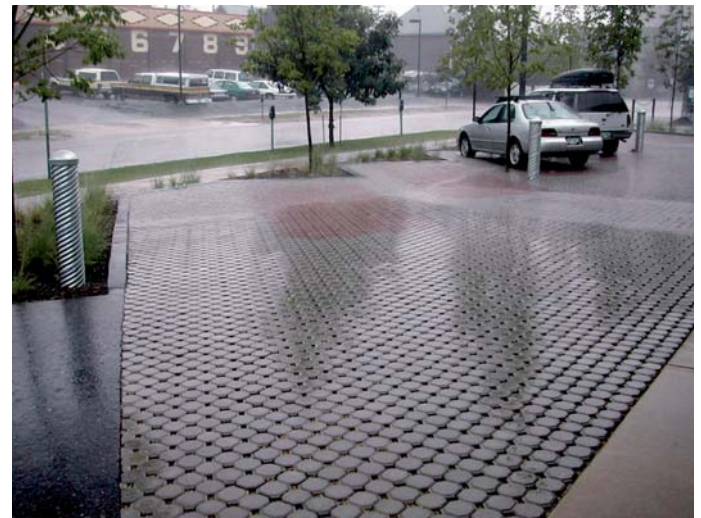
Fot. 2. Widok parkingu z nawierzchnią przepuszczalną (betonowa kostka z dylatacjami); źródło: Google Grafika
