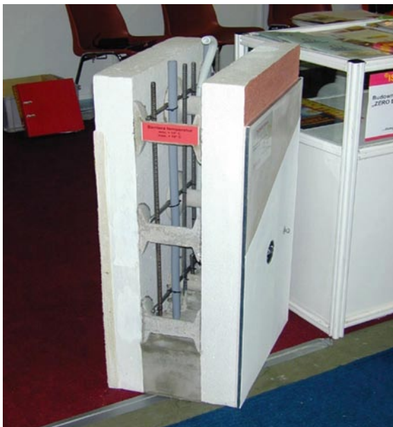
Rys. 7. Widok fragmentu ściany systemu ISOMAX przed zabetonowaniem
