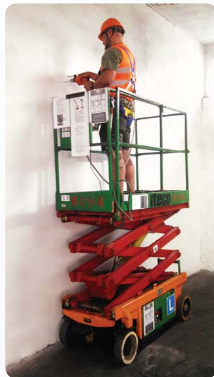
Fot. 5. Praca z użyciem wiertarki na podeście ruchomym przejezdnym
