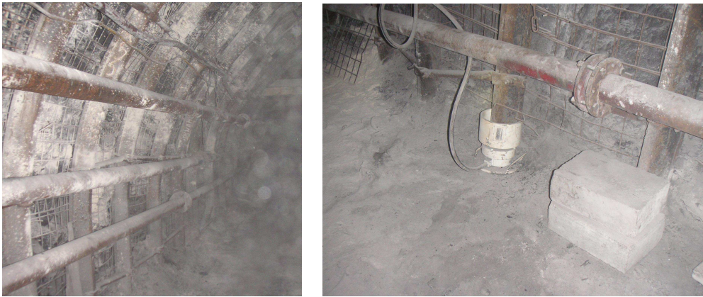
Fot. 5. Odrzvia SPŁ6.8-7.2/3.5/V29 ze stali S550 zabudowane w chodniku nadścianowym 3-Z1,Z2 w pokładzie 510/2 w kopalni „Jas-Mos” (Kuziak i in. 2012)
