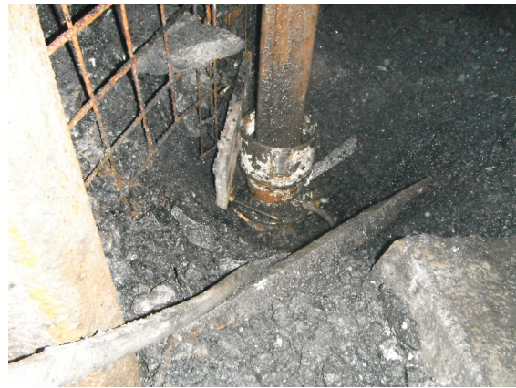
Fot. 3. Odrzwia ŁPw zabudowane w dowerzchni 3 badawczej w pokładzie 504 w kopalni „Bobrek-Centrum” (Kuziak i in. 2012)
