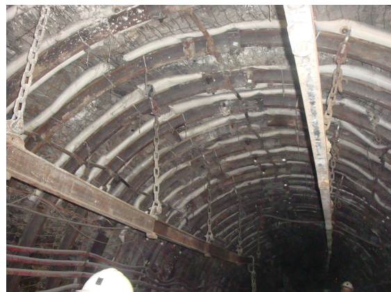
Fot. 4. Obudowa o podwyższonych parametrach mechanicznych II generacji zabudowana w chodniku nadścianowym ściany 6/VI/385, w pokładzie 385 w LW „Bogdanka” SA (Kuziak i in. 2012)
