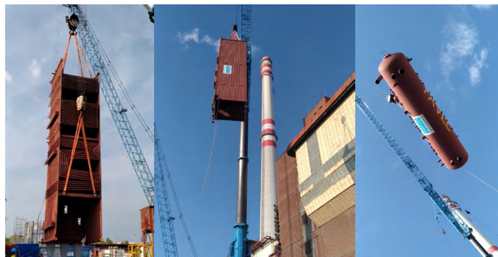
Fot. Realizacja dostawy czterech kotłów parowych do spalania odpadów komunalnych w Spalarni Odpadów w Malešicach (Praga, Republika Czeska).
