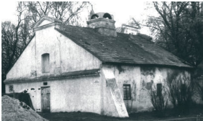
Rys. 2. Szpitalik murowany z 1757 r. – elewacje północna i zachodnia – lata 70. Źródło: wł. W. Libery
