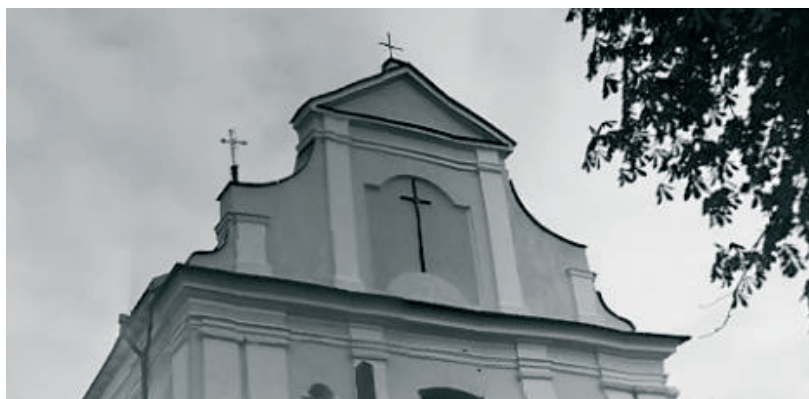
Rys. 4. Widok górnej części fasady kościoła Parafii Rzymskokatolickiej w Sawinie. Źródło: Google Street View
