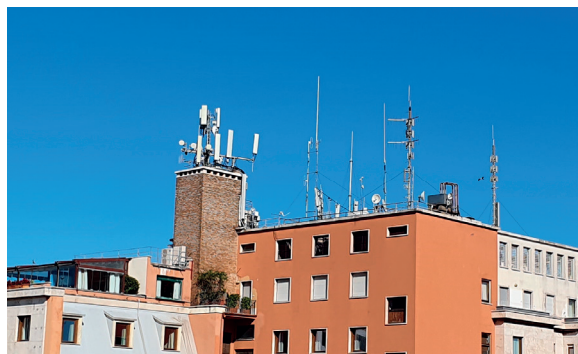
Ryc. 1 Typowe anteny systemów radiokomunikacyjnych na dachu budynku Źródło: Archiwum własne.
