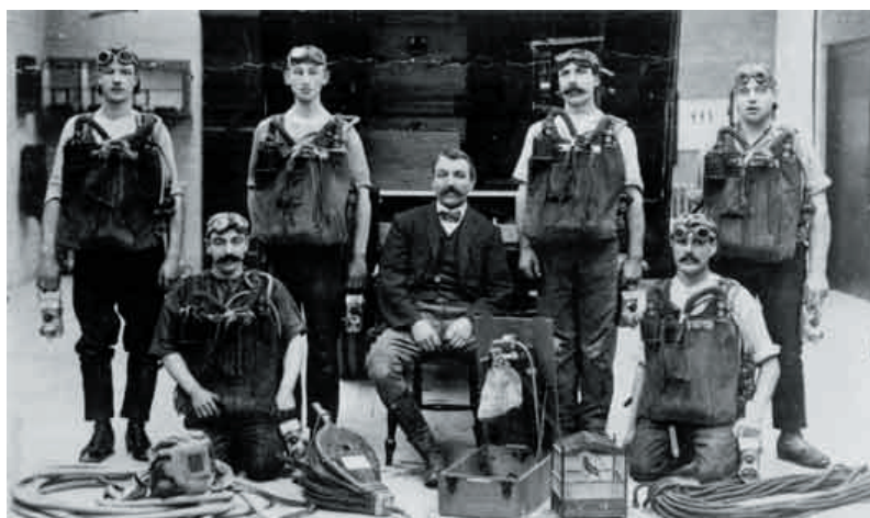
Ryc. 11. Minerska ekipa ratownicza, widoczne sprzęty ratownicze: miech kowalski, osobiste aparaty tlenowe Proto, zestaw tlenowy Novita, liny, lampy, klatka z kanarkiem (Barton, 2012)
