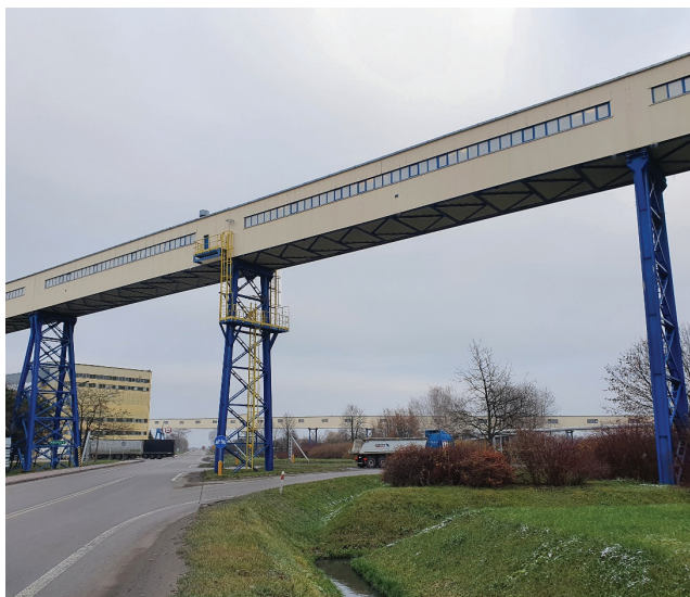
Rys. 2. Widok części jednego z segmentów mostu przenośnikowego; opracowanie własne
