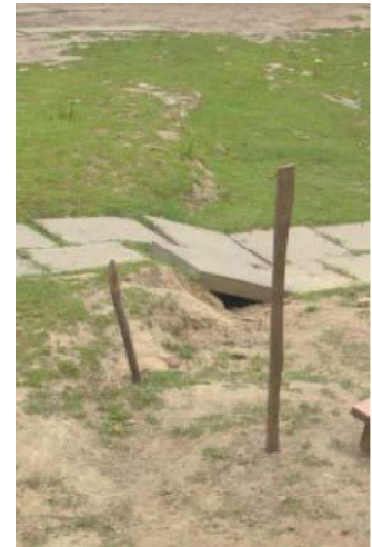
Rys. 4. Deformacje nieciągłe w terenie przyległym do pasa drogowego Fig. 4. Discontinuous deformations in the area adjacent to the roadway
