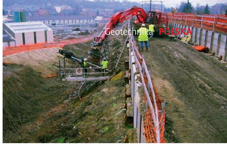
Ryc. 6. Wykonanie gwoździ gruntowych dla dobudowy toru, linia kolejowa Schaerbeek – Namur
