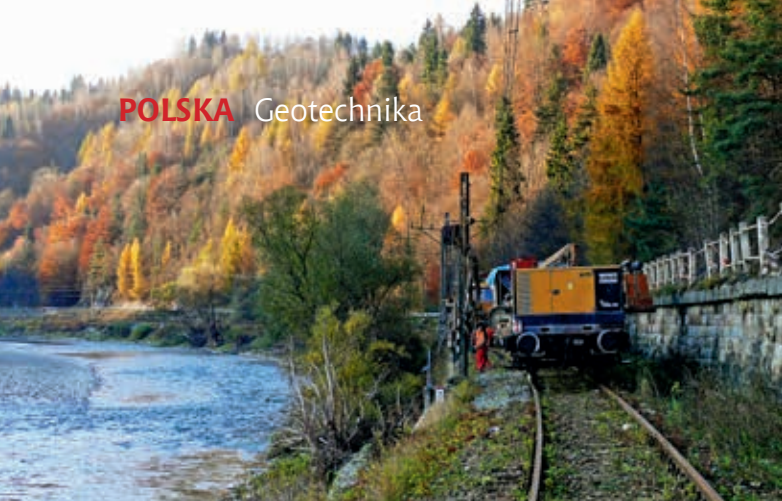
Ryc. 2. Wzmocnienie fundamentów słupów trakcyjnych, Piwniczna, fot. Soley Sp. z o.o.
