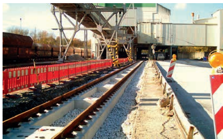
Ryc. 9. Nawierzchnia kolejowa bezpodсыpkowa NFF po wykonaniu, Kalkwerk Wülfrath
