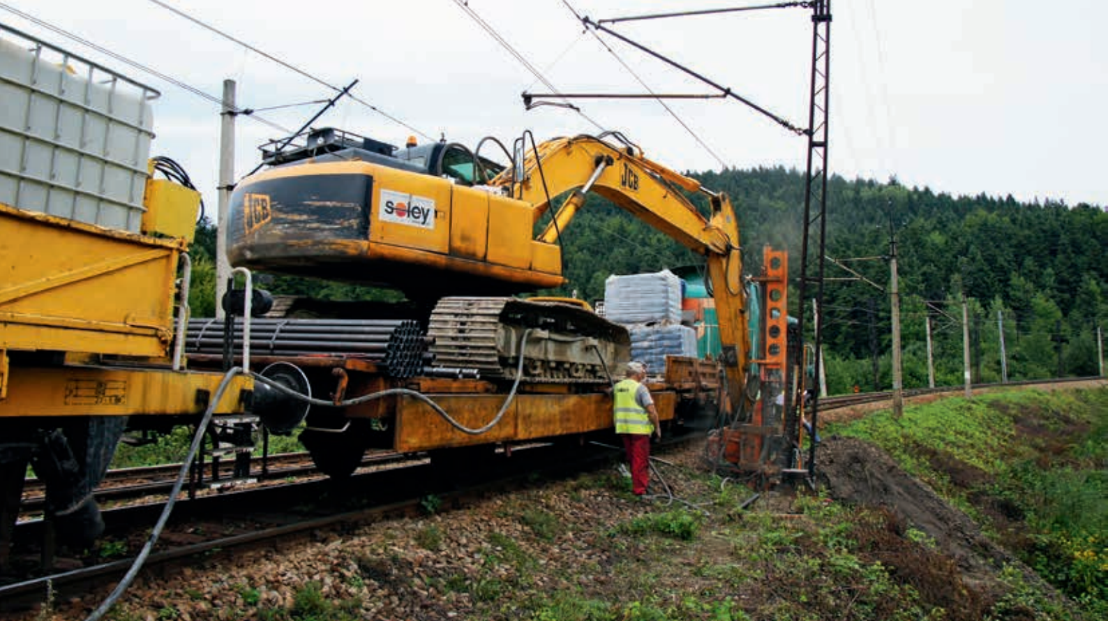
Ryc. 1. Instalacja mikropali pod stopy trakcyjne w miejscowości Ptaszkowa, fot. Soley Sp. z o.o.
