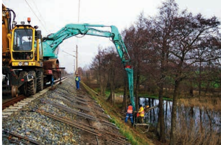
Ryc. 3. Wzmocnienie nasypu przez gwoździowanie z instalacją z toru, linia kolejowa Großenhain – Frauenhain
