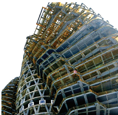
Rys. 3. Agora Garden – System konstrukcji ramowej (zdjęcie wykonane przez autorów)
