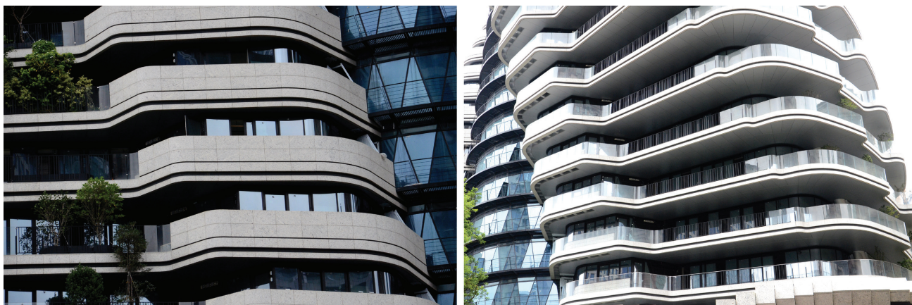
Rys. 7. Różnie ukształtowane balkony (zdjęcie wykonane przez autorów)
