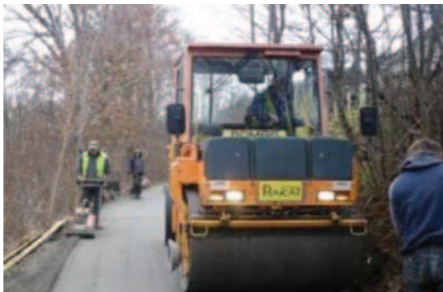
Rys. 4. Zagęszczanie ułożonej nawierzchni z betonu wałowanego – Miastko, ul. Fabryczna, 2009 r. (źródło: Firma Harat S.J.)
