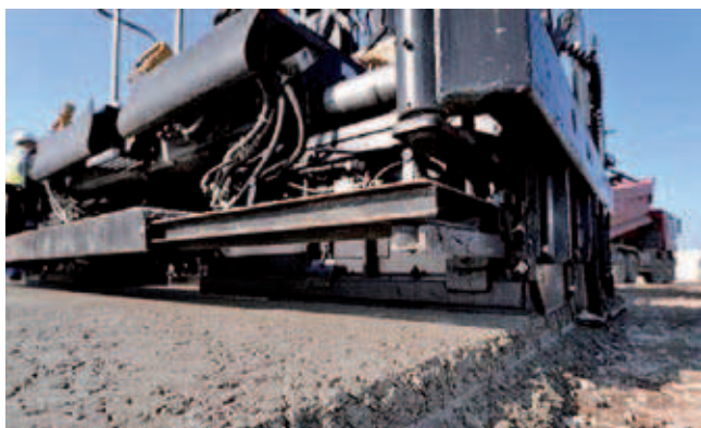
Rys. 3. Układanie nawierzchni w technologii betonu wałowanego za pomocą standardowego rozścielacza – lipiec 2013 (źródło: Lafarge)
