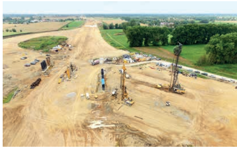
Droga S7 w km 55 + 400 – wzmocnianie podłoża w technologii żelbetowych pali formowanych w gruncie metodą przemieszczeniową (najazd na obiekt WD-26), zarys węzła Elbląg Zachód
