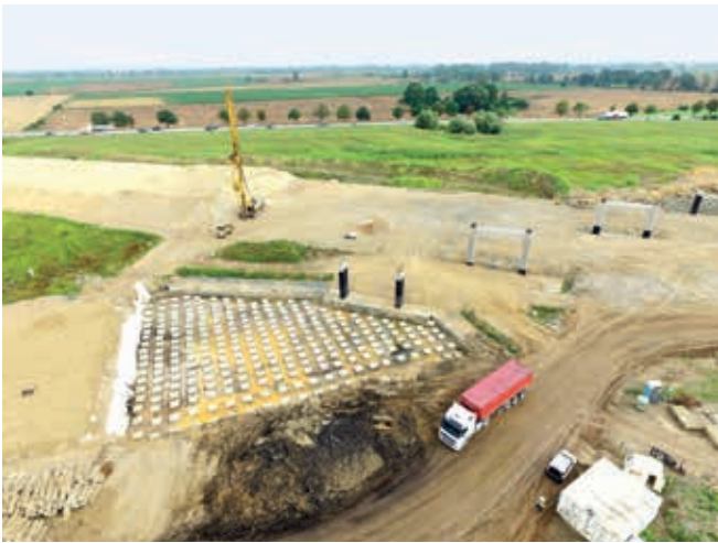
Droga P-14 w km 0 + 800 (najazd na obiekt WD-18) – wzmocnienie podłoża w technologii żelbetowych pali formowanych w gruncie metodą przemieszczeniową, zwieńczone oczepami
