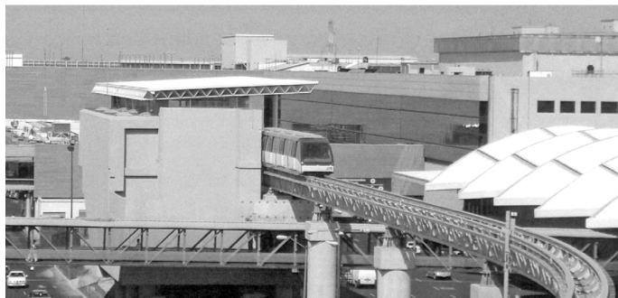
Fot. 4. Stacja tramwaju linowego na lotnisku w Mexico City [2]
