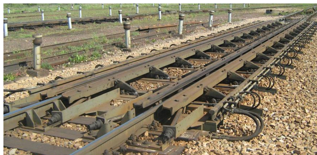
Rys. 1. Hamulec szczękowy typu ETH - odstępowy [fot. autor]
