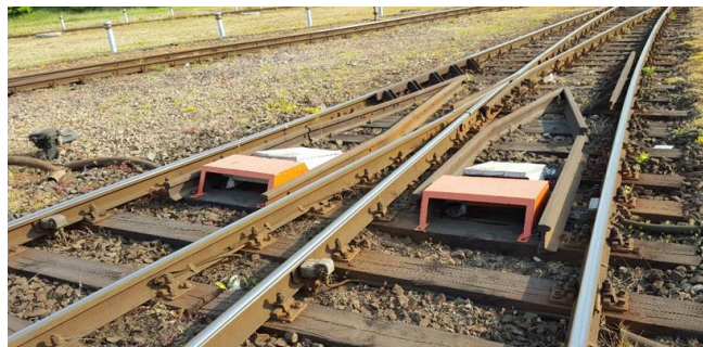
Rys. 3. Radarowe mierniki prędkości na stacji rozrządowej [fot. J. Tyszkowski]
